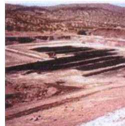
Superficie para secar los lodos a través de la acción del Sol.
